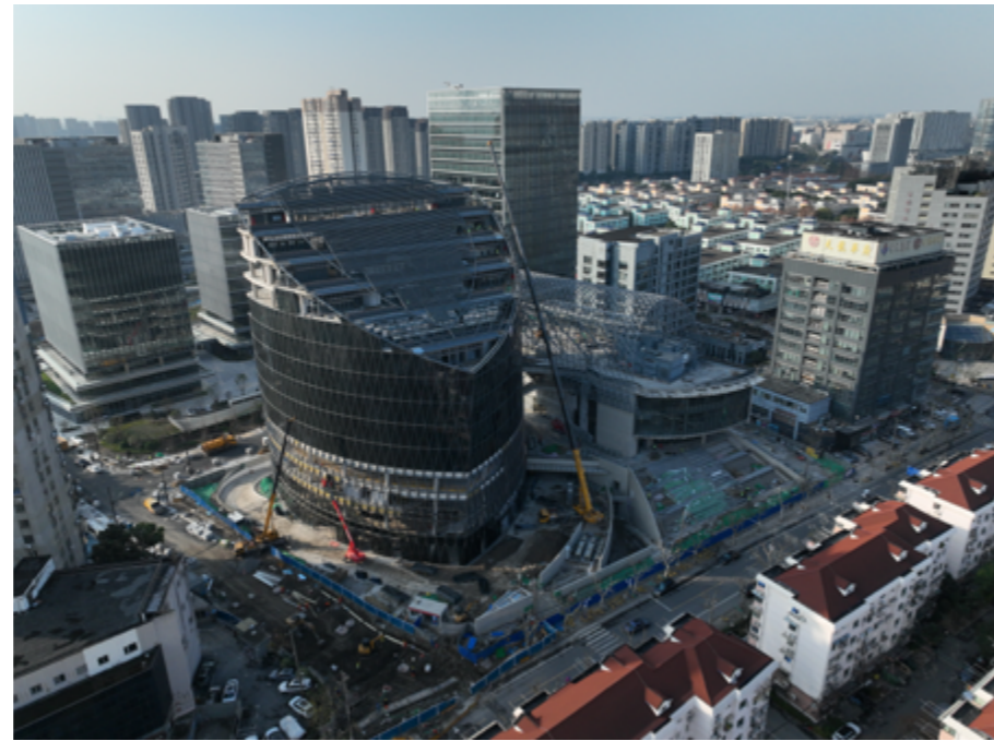
波克中心建筑航拍 (摄于2025年12月)
