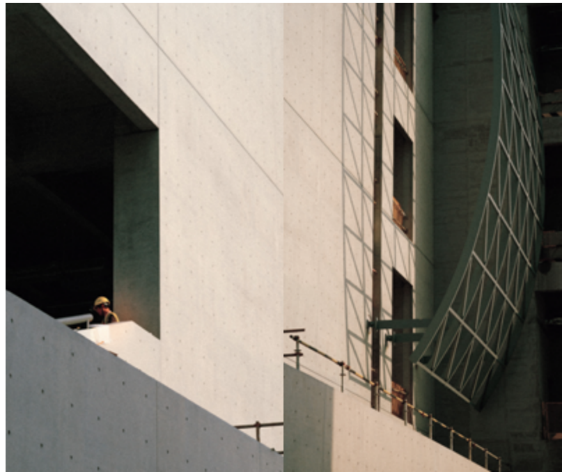
波克艺术中心清水建筑外观
