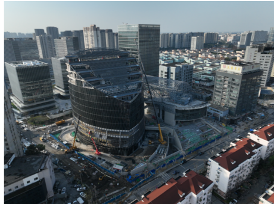
波克中心建筑航拍 (摄于2025年12月)
